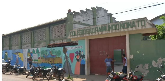
Figura 1. Imagem da Fachada da Escola, na Cidade de Santarém-Pa.
