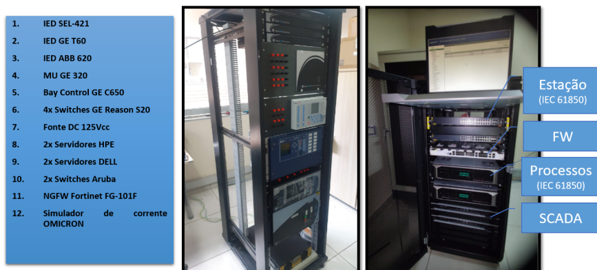
Figura 4. Infraestrutura de uma SG da Neoenergia com a implantação do Hórus-CDS
