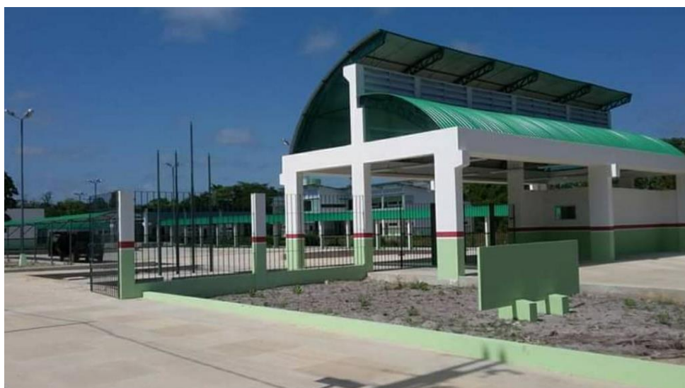
Figura 2 - Prédio do IFPA Campus Breves após construção
