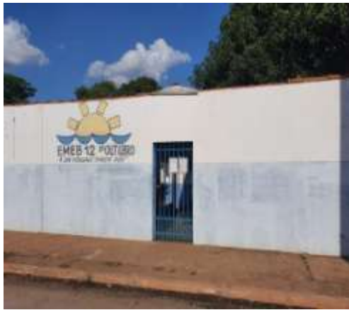
Figura 4. Fachada da EMEN 12 de Outubro- 2021
