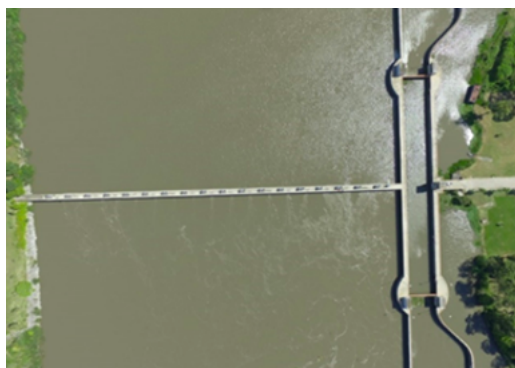
Figura 1. Barragem Eclusa do São Gonçalo
