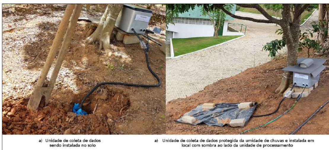
Figura 5: Instalação do equipamento
