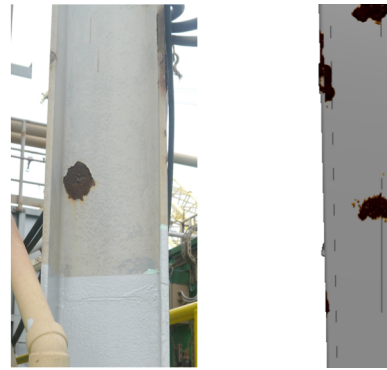
Figura 8. Comparação entre viga de plataforma (esquerda) e malha com rugosidade e cor (direita).
