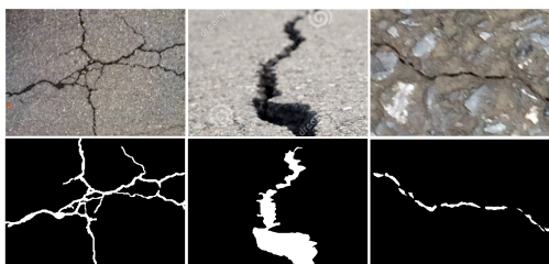
Figura 3. Exemplos de imagens do conjunto DeepCrack, adaptado de [2].
